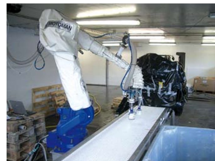
Prototype installert hos Brødrene på Ellingsøy
